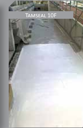
FACTORY ROOF MRIEHEL
